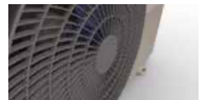
Luchtuitlaat in de vorm van Archimedes-schroef
